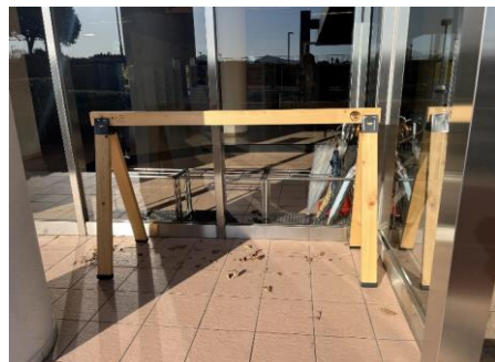
御殿場市体育館
